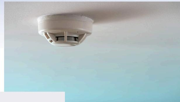
O detector de fumaça contém uma fonte radioativa Am-241
